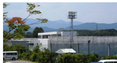
▲改装中の学遊館
