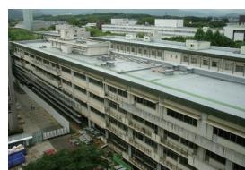
2017.7.14 解体の足場が組み立てられ始める。
