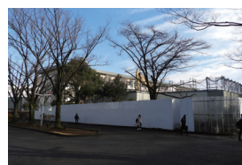
2018.1.9 解体は西側に達した。増築部分が残る。
