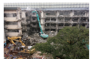
2017.8.31 東側の半分が壊される。壁を残して粉塵除けに。
